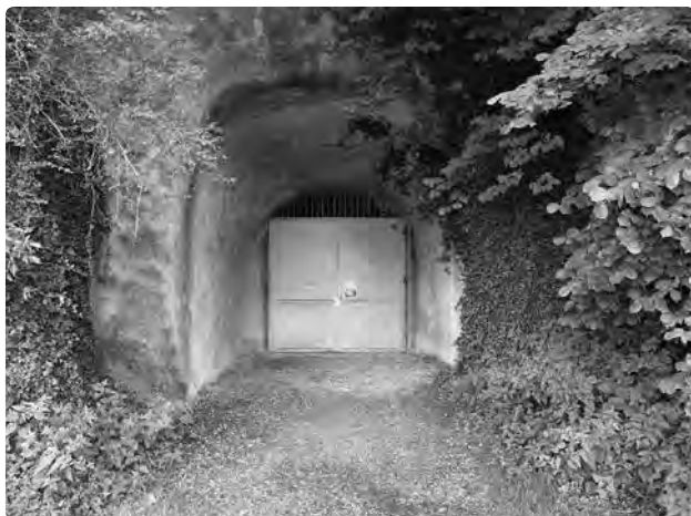
Stolleneingang Goldbacher Stollen
